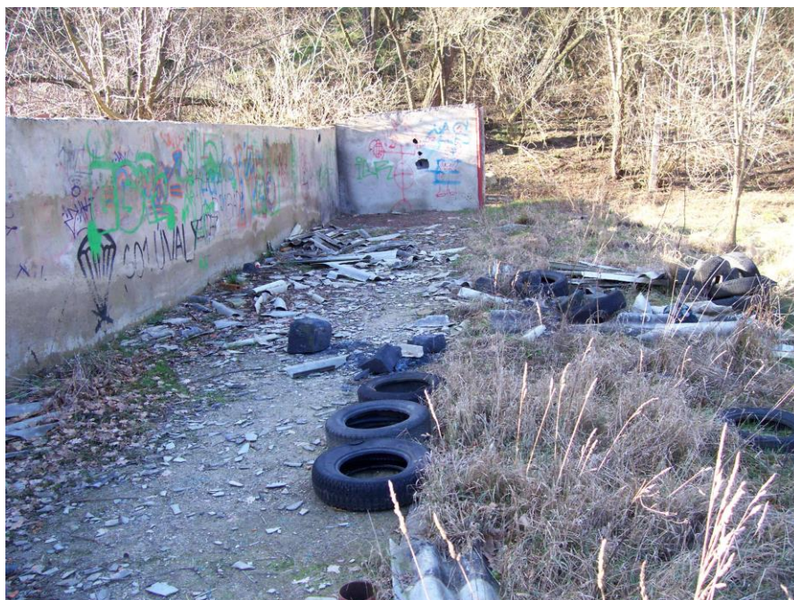
Objekt bývalé střelnice v severní části údolí Výmoly – dnes potenciálně kriminogenní oblast ...
